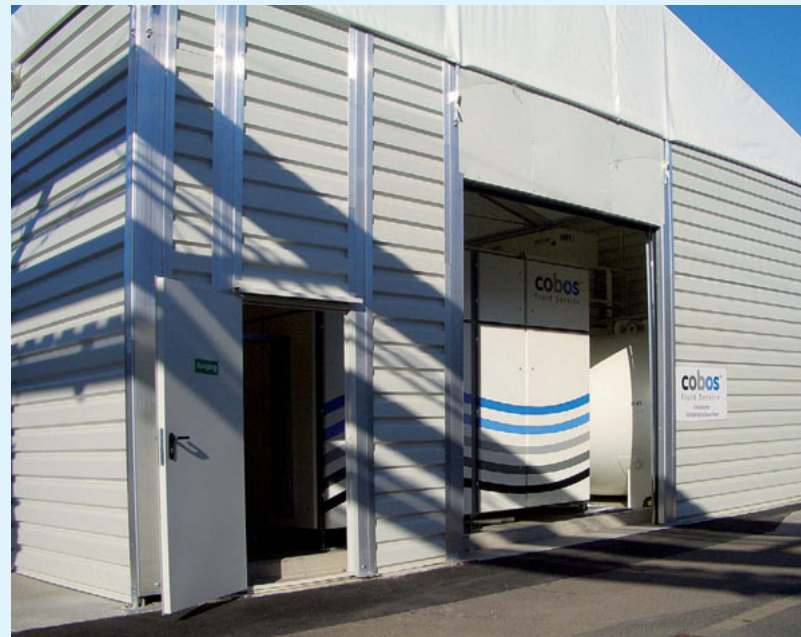
LEICHTBAUHALLE BEI SKF: Im Inneren erfolgt die Behandlung von Prozesswasser
